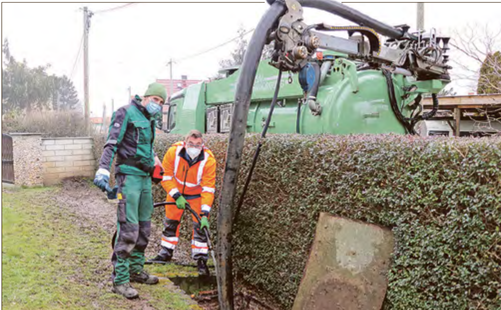
Ortstermin in Lützen, OT Kaja: Sandro Piehler (re.) vom ZWA Bad Dürrenberg und Christoph Engelmann von der Entsorgungsfirma Jirsak GmbH pumpen die abflusslose Sammelgrube eines dezentral zu entsorgenden Grundstücks ab.
