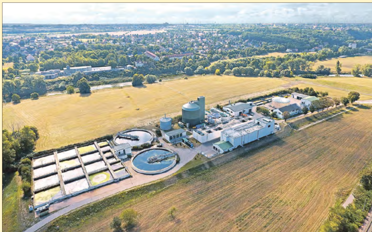
Die Kläranlage in Weißenfels steht im Zentrum zukunftssträchtiger Investitionen bei der Abwasserbeseitigung Weißenfels-AöR.
