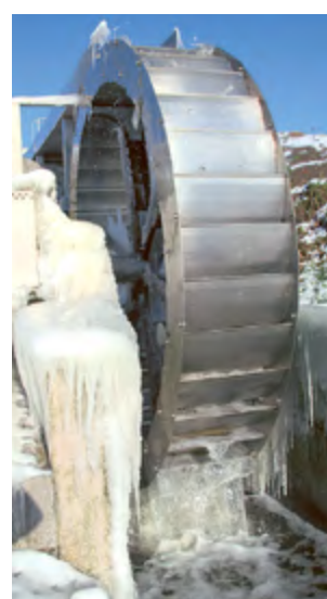
Das Wasserrad auf der Kläranlage in Hillersleben.
