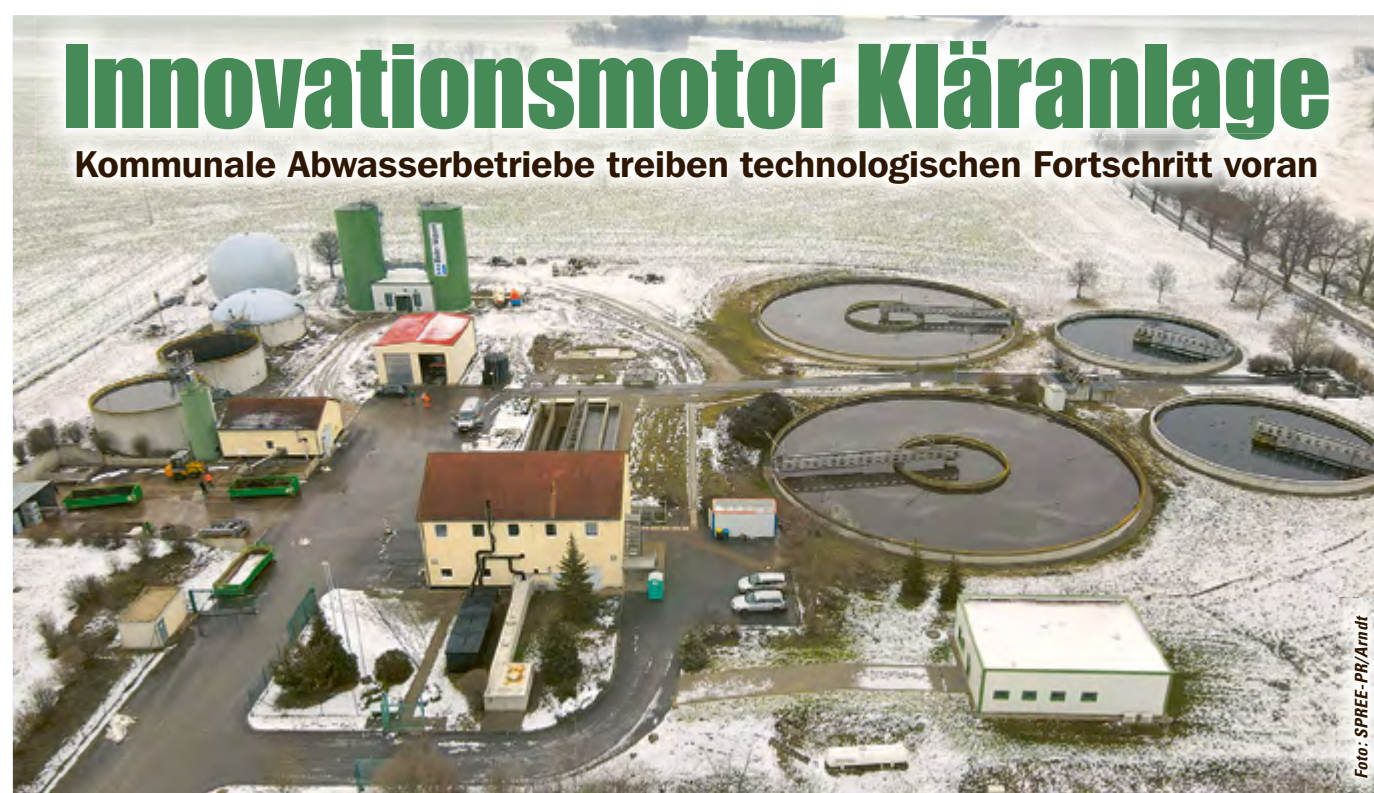
Die Verbandskläranlage des WAZV „Bode-Wipper“ in Staßfurt wurde gerade aufwendig energetisch saniert. Dank der neuen Klärgas-erzeugung (in den grünen Türmen oben links) wird nun selbst Strom produziert und auf der Anlage genutzt. Die Ersparnis ist enorm.
