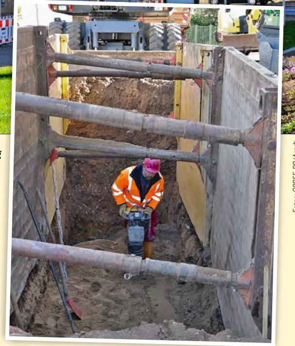
An der Kurhausstraße in Bad Dürrenberg wird aktuell gebaut. Hier kommen neue Schmutzwasserkanäle unter die Erde. Außerdem werden Regenwasserkanäle und die Trinkwasserleitung erneuert.
