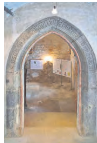
Eine Spitzbogentür führt in die historische Krypta.
