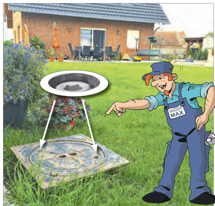
Hausanschlussschächte müssen gut sichtbar und zugänglich sein.
