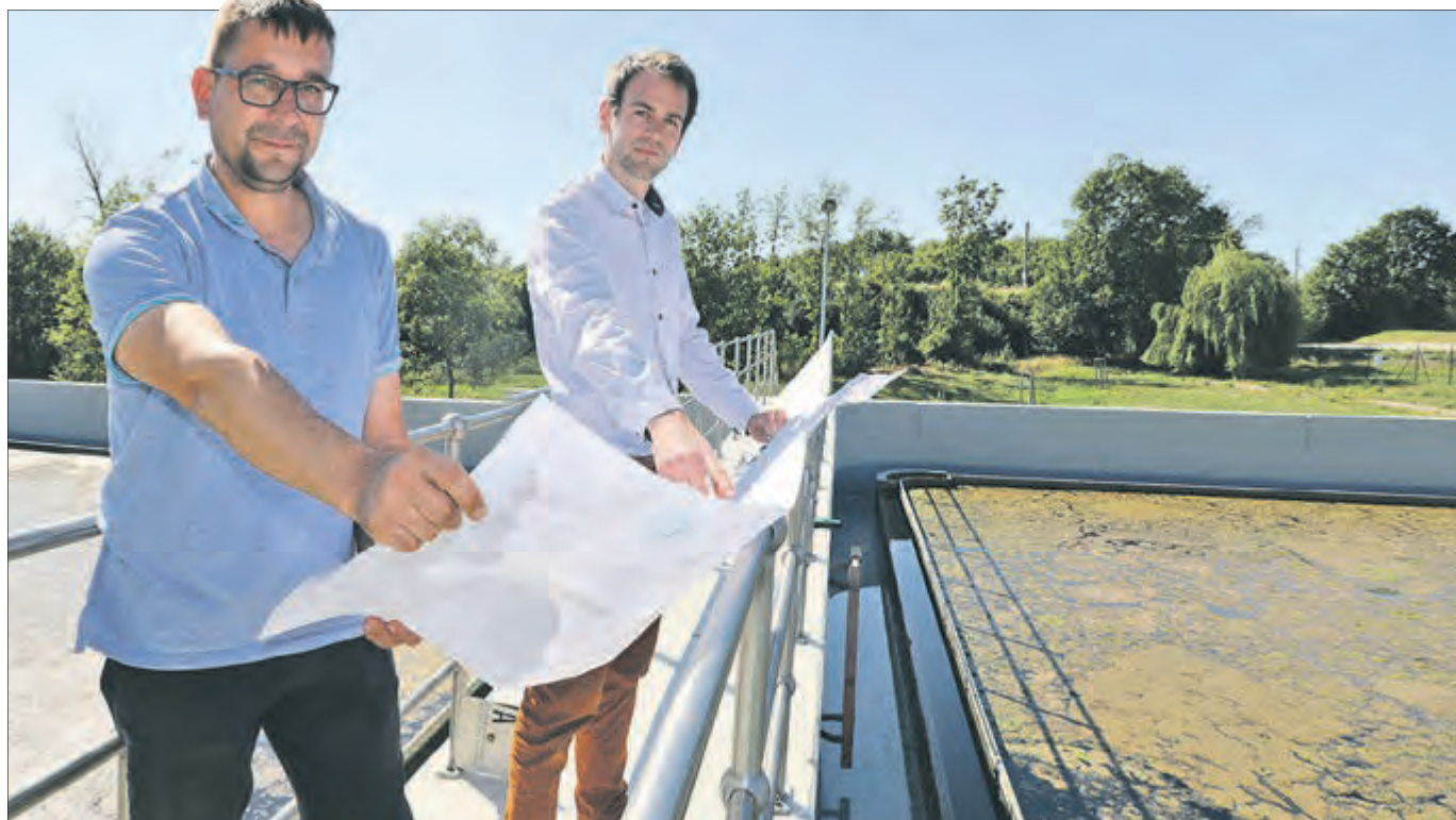
Die drei Nachklärbecken auf der Kläranlage in Bad Dürrenberg strahlen seit Kurzem in neuem Glanz. Dank des Einsatzes von Martin Dobischok (rechts) und Sandro Piehler vom ZWA Bad Dürrenberg konnten die veralteten Anlagen saniert werden.
