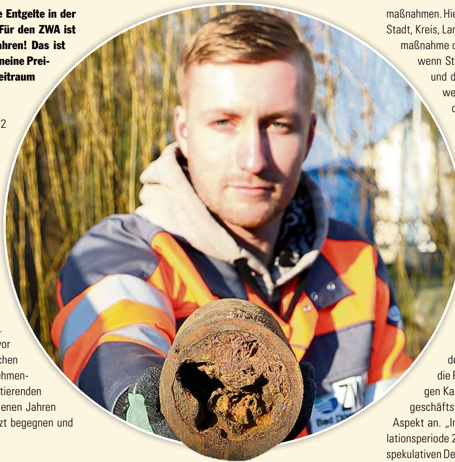
Tim Tässmann vom ZWA zeigt ein zugesetztes Trinkwasserrohr. Alte Rohe dieser Art bereiten vor allem beim Wasserdruck Probleme.
