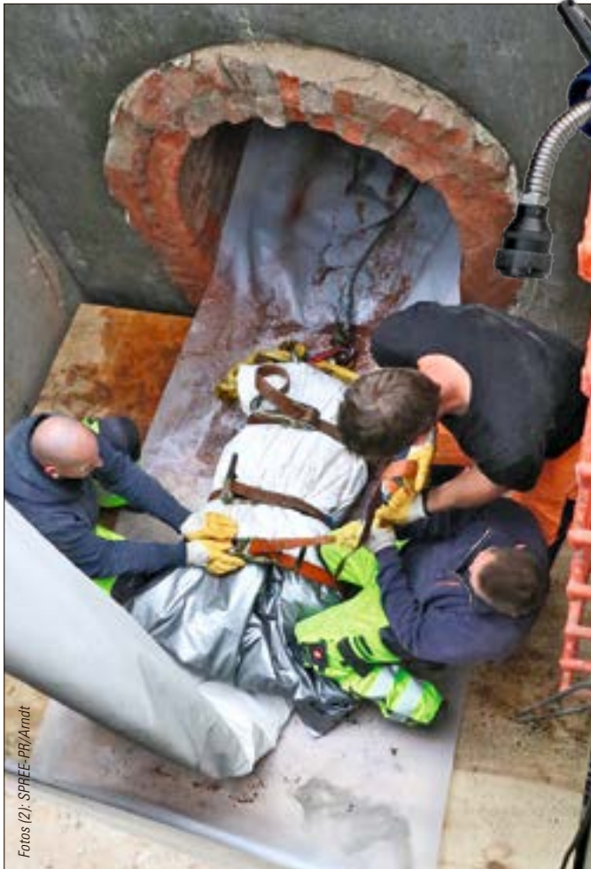
So geht Kanalsanierung heute. An der Zeitzer Straße wurde der Kanal mittels grabenlosem Verfahren erneuert. Dafür wurde ein 30m langer Schlauch aus Kunstharz in den beschädigten Kanal eingeführt.
