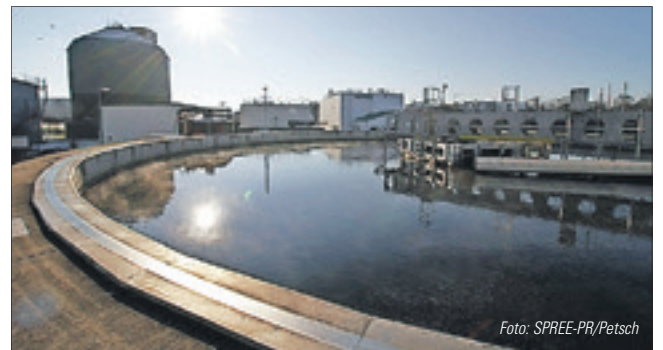
Die Ausbaugröße der Kläranlage am Weißenfeler Saaleufer trägt dazu bei, die Gebühren auf moderatem Niveau zu halten.
