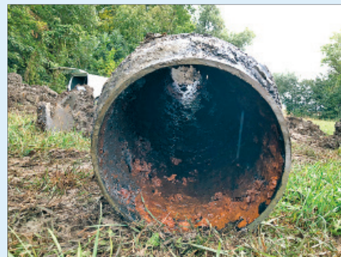
Es dauerte den ganzen Tag, ehe diese beschädigte Rohrleitung aus den 1960er Jahren entfernt und durch eine neue ersetzt war.
