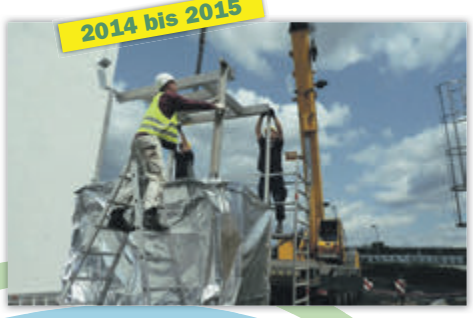
Die Kapazität der Kläranlage wird auf 125.000 Einwohnerwerte erhöht. Investitionen, die für die Reinigung industrieller Abwässer nötig waren, wurden zu großen Teilen aus Fördergeldern bestritten.
