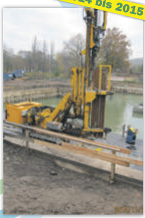
Neubau der Regenüberlaufbecken 2 und 6.
