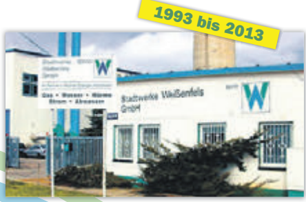
Betriebsführung durch die Stadtwerke Weißenfels GmbH.
