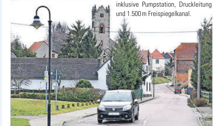
Kleinkorbetha wird derzeit noch dezentral entsorgt.
