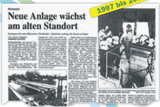
Erstausbau der Kläranlage Weißenfels auf 76.500 Einwohnerwerte, die Lokalpresse berichtete ausführlich.
