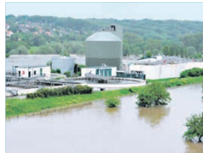
Land unter: Die Weißenfelser Kläranlage war 2013 besonders stark vom Hochwasser betroffen.
