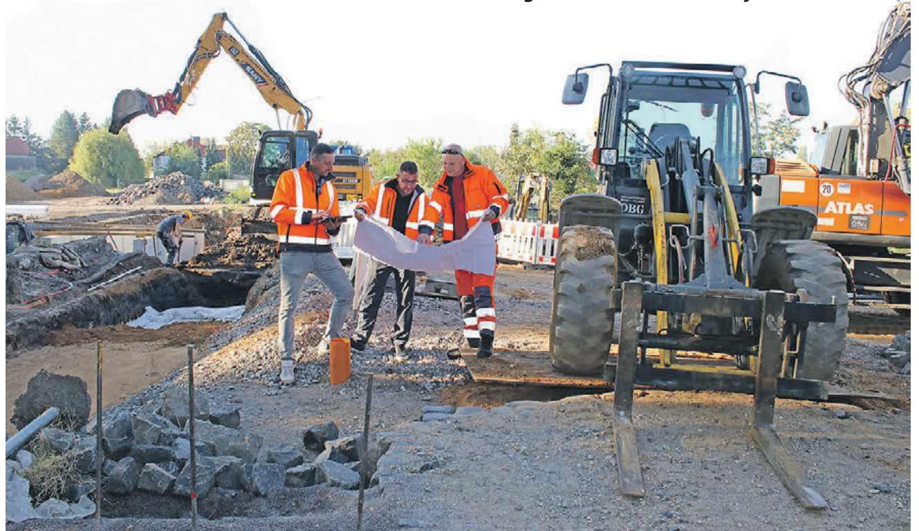
Die ZWA-Mitarbeiter Steffen Land, Ingenieur Investitionen und Anschlusswesen, Sandro Piehler, Abwassermeister, sowie Thomas Simmert (v. l.), stellv. Abwassermeister, auf der Baustelle Schweißwitzer Straße in Lützen, einem Großprojekt des Verbandes 2023. Foto: SPREE-PR/Wolf
