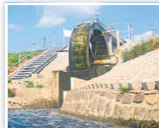
Seit 2012 wird beim Abwasser-verband Haldensleben „Untere Ohre“ Strom per Wasserrad erzeugt. Foto: AVH „Untere Ohre“
