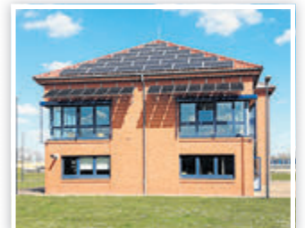
Sonnenenergie einfangen: Der VKWA Salzwedel betreibt mehrere Solaranlagen. Foto: VKWA Salzwedel
